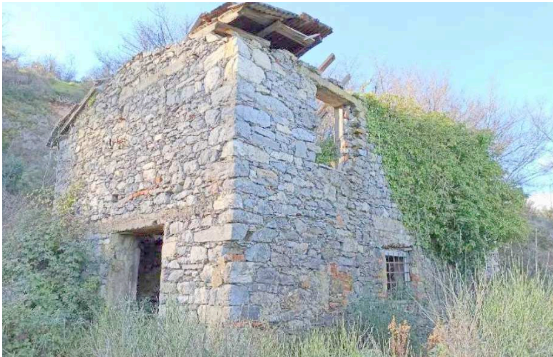
Foto 3 – Fabbricato di progetto
