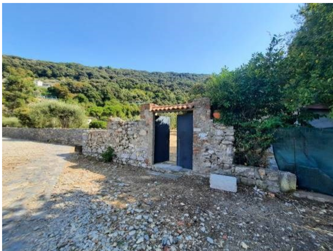
Figura 6 – il muro in pietrame di delimitazione lato spiaggia
