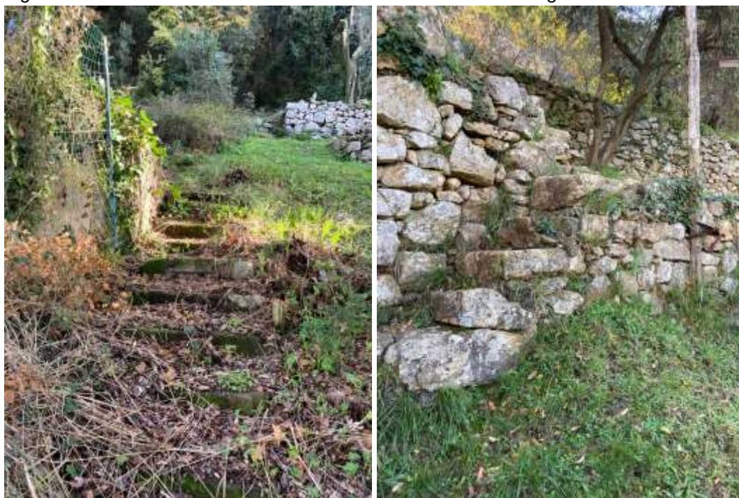
Figure 11 e 12 il cedimento dei muri a secco e delle scale di collegamento
