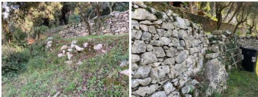
Figure 11 e 12 il cedimento dei muri a secco e delle scale di collegamento
